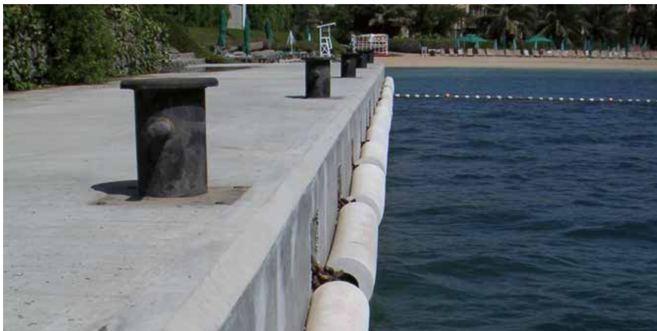
Leisure Jetty, Kota Kinabalu, Malaysia
